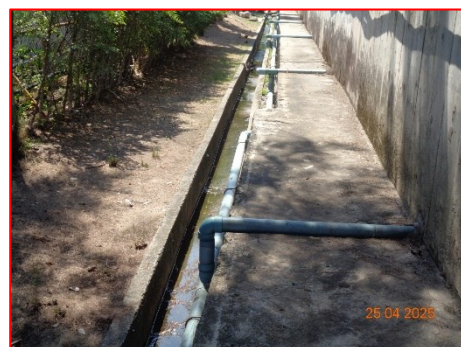
ภาพที่ 2.3-18 ท่อรวบรวมน้ำฝนปนเปื้อน บริเวณลานเก็บกองวัตถุดิบ
