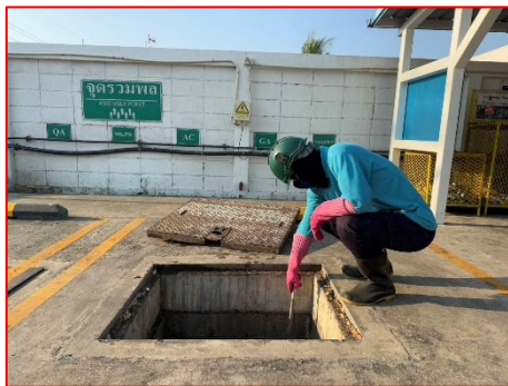
ภาพที่ 2.3-15 พนักงานทำความสะอาด บ่อดักน้ำมันและอลูมิเนียม (Oil & Sand Trap)
