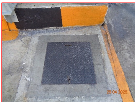
ภาพที่ 2.3-17 บ่อดักน้ำฝนปนเปื้อน ขนาด 400 ลิตร
