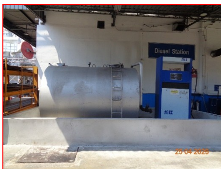
ภาพที่ 2.3-43 กำแพงล้อมรอบถังเก็บกักน้ำมันดีเซล
